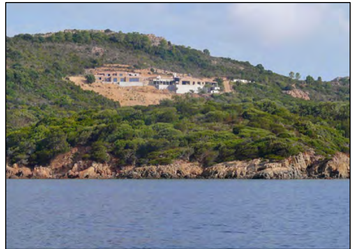
Les villas Ferracci dont la démolition est demandée.
