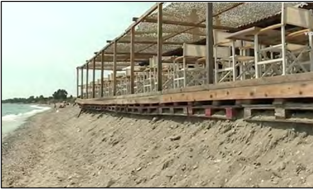
La paillote Crocodile Bar, à Solara, à présent démolie.
