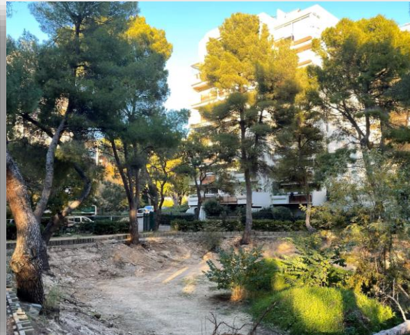
Pavés et chape de béton totalement retirés. Arbres implantés dans un talus avec pour certains des inclinaisons marquées et des mâts racinaires peu développés
