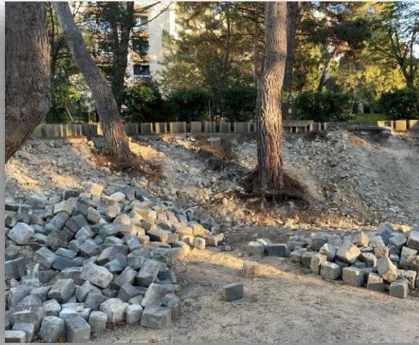
Pavés et chape de béton partiellement retirés : décaissement sur environ 50 cm de profondeur
