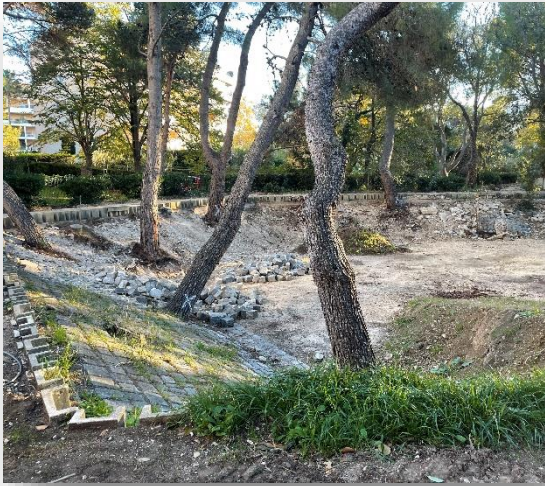
Pavés et chape de béton partiellement retirés : décaissement sur environ 50 cm de profondeur
